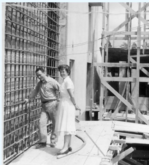
Professora Ewa durante construção da torre do Pelletron no IFUSP.
