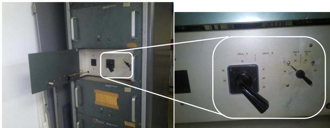
Figura 11 - Seletor das fontes de quadrupolo das canalizações (Q5)
