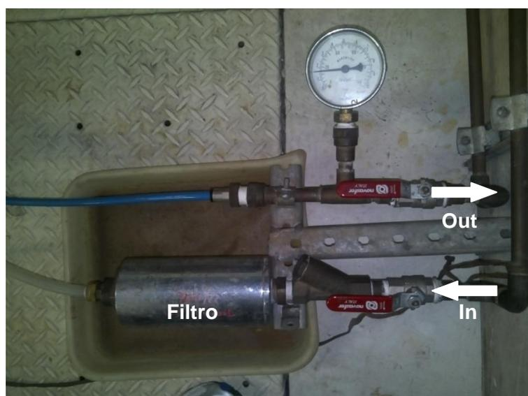
Figura 13 - Manômetros de água de entrada e saída das fontes de corrente do switching magnetic.
