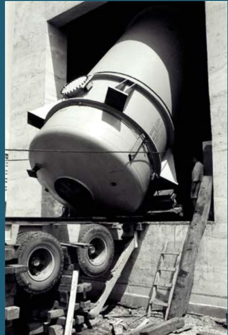
Chegada e instalação dos tanques do 4U e do 8-UD dentro da torre (29/03/1971)
