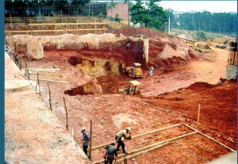
Construção das instalações do acelerador: escavação dentro do muro de arrimo
