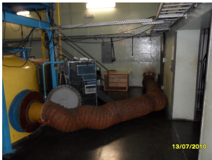
Figura 1: Circulação de ar no tanque.
