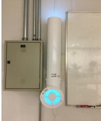
Este dispositivo consiste em um tubo de PVC de 150 mm de diâmetro, tendo numa de suas extremidades um joelho de 90° que por sua vez, está acoplado a uma ventoinha compacta, com vazão de 180 m<sup>3</sup>/h.
